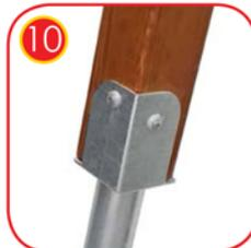
10 Holzposten werden mit Pfostenschuhen montiert.
